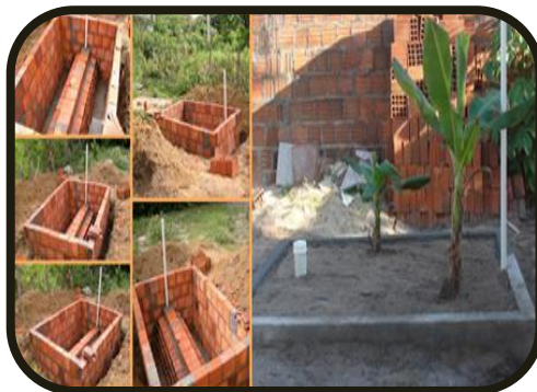
No campo do saneamento básico
